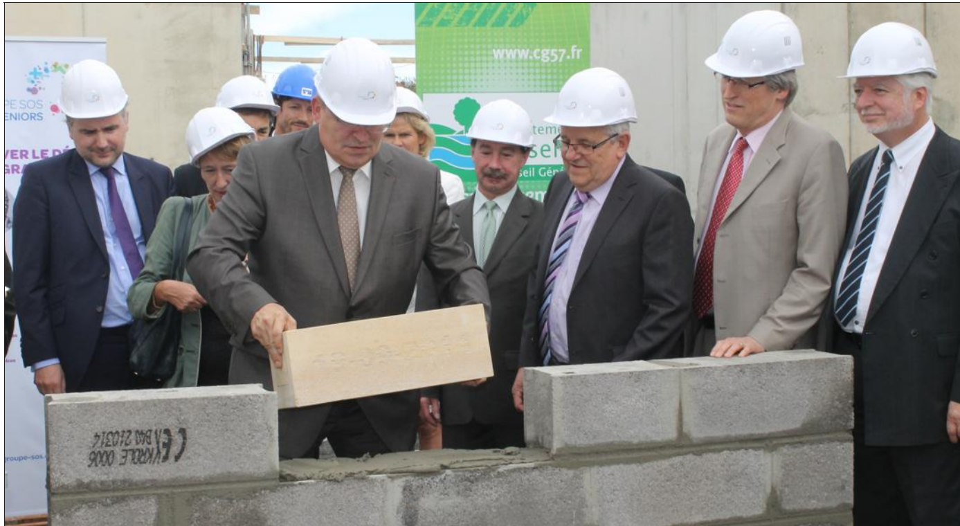
Hier après-midi, la pose de la première pierre a été plus que symbolique, car un étage est déjà monté. Photo RL
