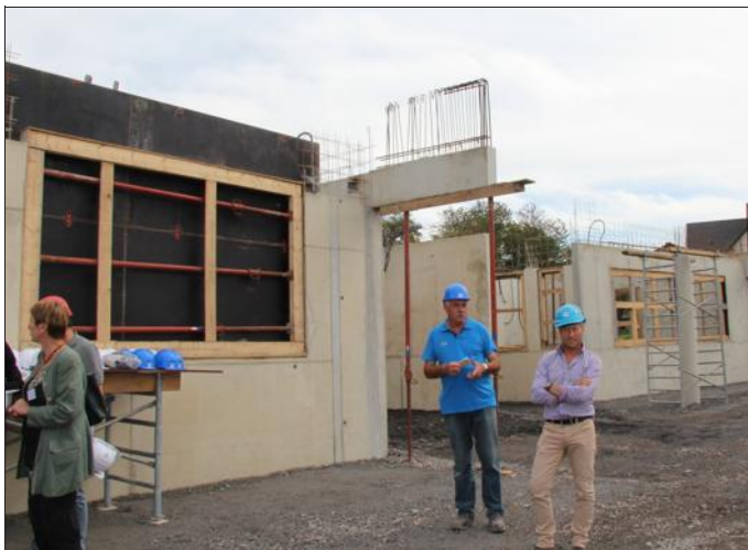
Le chantier a débuté au printemps. Il doit être terminé fin 2015. Photo RL
